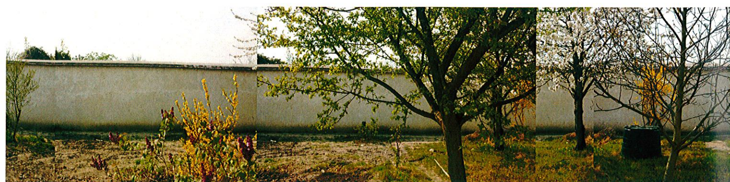
Le même mur après restauration (2012)
