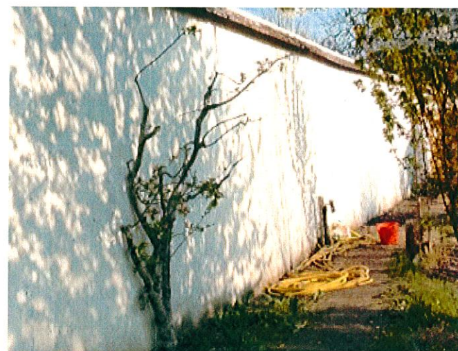
Vu de l'enduit de finition terminé : l'enduit n'est pas complètement droit, il suit la maçonnerie.
