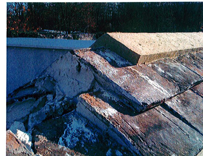
Chaperon couvert en tuiles plates de remploi en cours de mise en œuvre
