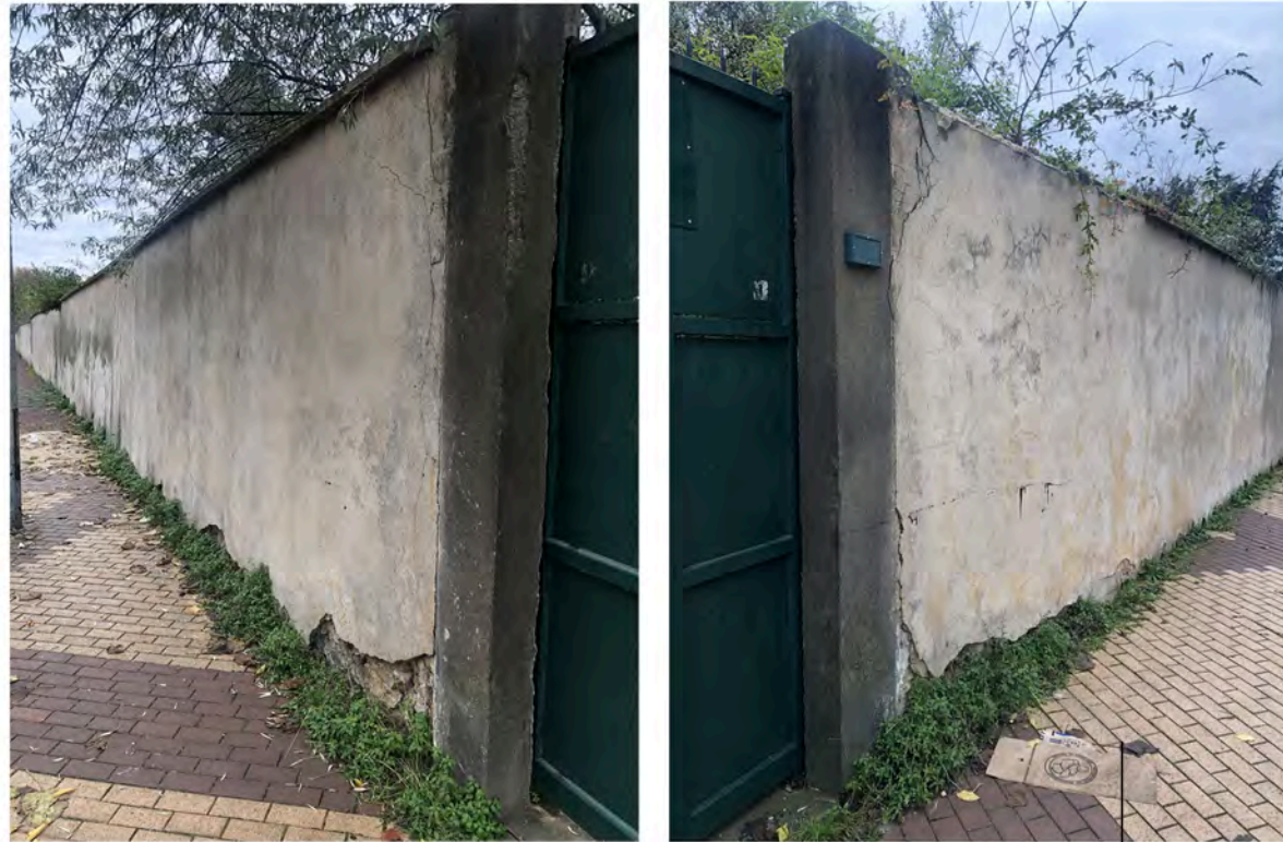
Reprise de maçonnerie en soubassement
