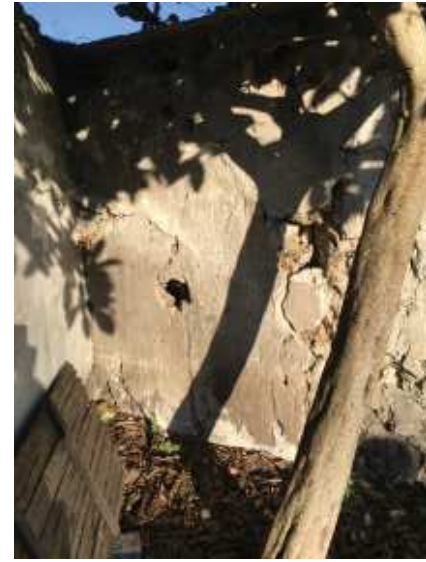
Mur E : Fragilité à l'angle nord - chaperon + reprise ponctuelle
