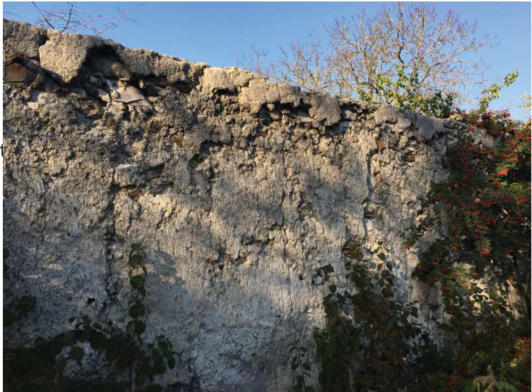
Mur B : redressage + restauration + refecton chaperon + enduit ou plâtre pour enduit
