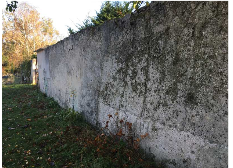
Mur B : redressage + restauration + refecton chaperon + enduit ou plâtre pour enduit
