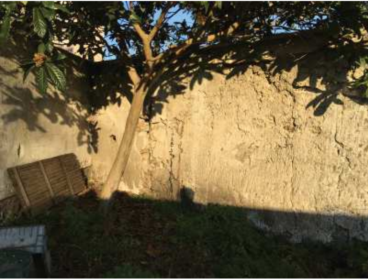
Mur E : Fragilité à l'angle nord - chaperon + reprise ponctuelle
