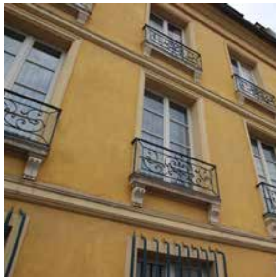
Fig.168. A gauche, édifices parisiens dont des bavettes de zinc recouvrent chaque bandeau, soulignant la façade de lignes noires. A droite, édifice versaillais dont les bandeaux ne sont pas recouverts de bavette, la façade est adoucie. Source : Tiffanie Le Dantec.
