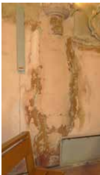
Fig.161. L'église d'Othis (77) possédait des enduits intérieurs en plâtre, partiellement recouverts d'enduits de ciment. En présence d'eau capillaire, la formation d' ettringite a provoqué le gonflement et la fissuration des enduits de ciment. Source : Aurélie Randon, architecte du patrimoine.
