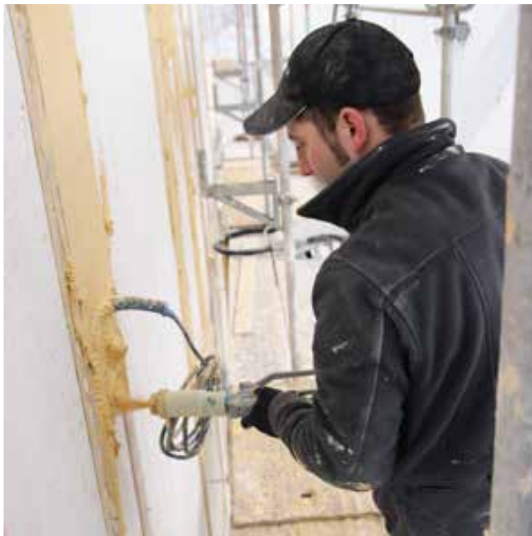
Fig.158. Projection de la couche de finition de l'enduit au plâtre de nos jours. Le plâtrier va pouvoir la travailler manuellement, économisant ainsi ses forces pour le travail délicat. Source : Tiffanie Le Dantec.
