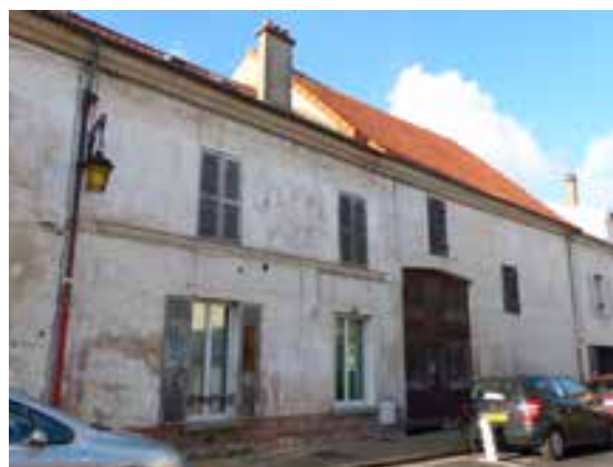
Fig.111. De la riche maison bourgeoise à la ferme, le vocabulaire de la façade en plâtre est présent : soubassement, bandeaux, corniche et murs de cette teinte blanche délavée caractéristique. Source : Tiffanie Le Dantec.
