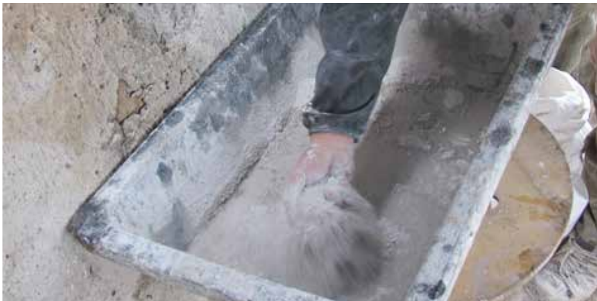
Fig.62. Gâchage manuel du plâtre, dans un volume d'eau le plâtre est saupoudré jusqu'à affleurer à la surface. Source : Tiffanie Le Dantec.
