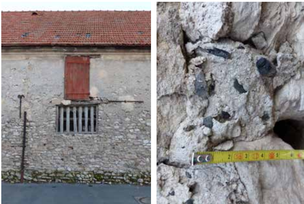
Fig.38. Plâtre gris rural utilisé en liant de maçonnerie et en enduit d'une ferme près de l'église de Charny (77), ce matériau artisanal est chargé de suie et de charbons. Source : Tiffanie Le Dantec.
