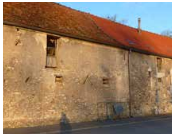
Fig.115. La ferme de gauche est située à Tilly, à l'extrême ouest des Yvelines (78). La ferme de droite est située à Charny, au nord de la Seine-et-Marne en Brie. Elles présentent le même type d'enduit de plâtre : en fine épaisseur, un matériau très grossier et chargé d'impuretés de l'ordre du centimètre de diamètre. L'érosion crée un effet «à pierre-vue» sur les parties de la façade les moins protégées.
