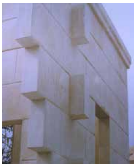
Fig.210. Prototype de l'ouvrage monté à Dakar au Sénégal, en carreaux de plâtre imbriqués. Source : Agence Mauduit & Alluin, Jean-Paul Mauduit.
