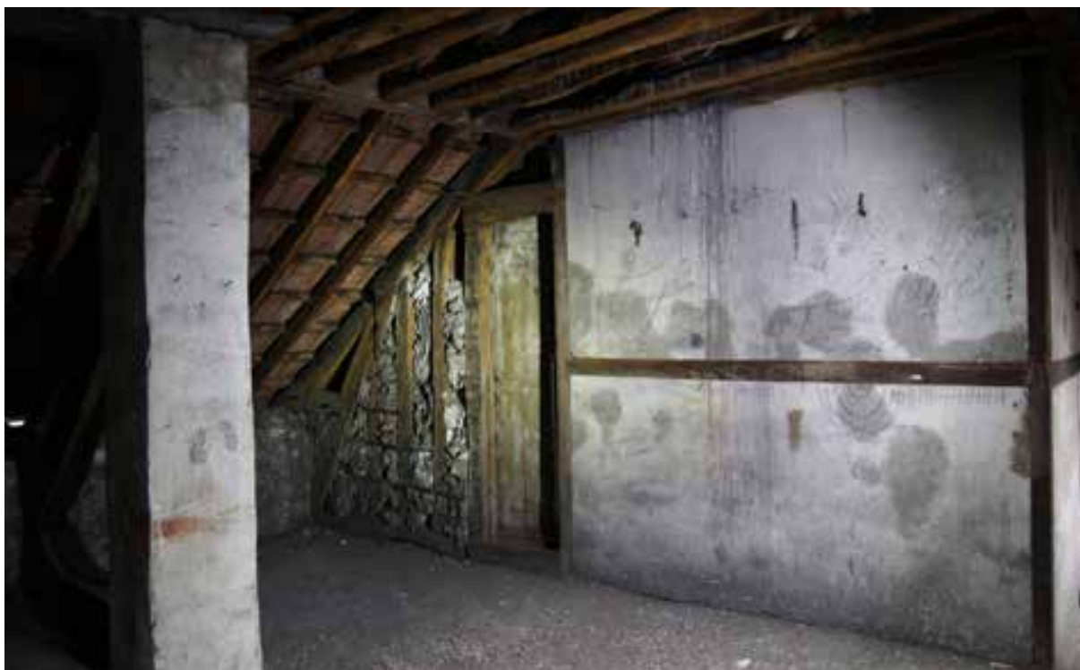
Fig.88. Grenier du 15, rue de la Pierre Levée à Paris. Cet espace est resté intouché depuis la fin du XIXe siècle et témoigne des usages du plâtre dans la construction : fumiserie, cloisons, hourdis, enduits, maçonnerie etc. Source : Tiffanie Le Dantec.
