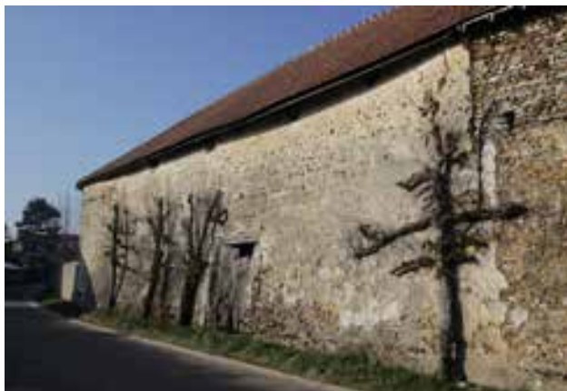
Fig.115. La ferme de gauche est située à Tilly, à l'extrême ouest des Yvelines (78). La ferme de droite est située à Charny, au nord de la Seine-et-Marne en Brie. Elles présentent le même type d'enduit de plâtre : en fine épaisseur, un matériau très grossier et chargé d'impuretés de l'ordre du centimètre de diamètre. L'érosion crée un effet «à pierre-vue» sur les parties de la façade les moins protégées.
