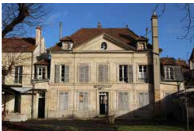
Fig.111. De la riche maison bourgeoise à la ferme, le vocabulaire de la façade en plâtre est présent : soubassement, bandeaux, corniche et murs de cette teinte blanche délavée caractéristique. Source : Tiffanie Le Dantec.
