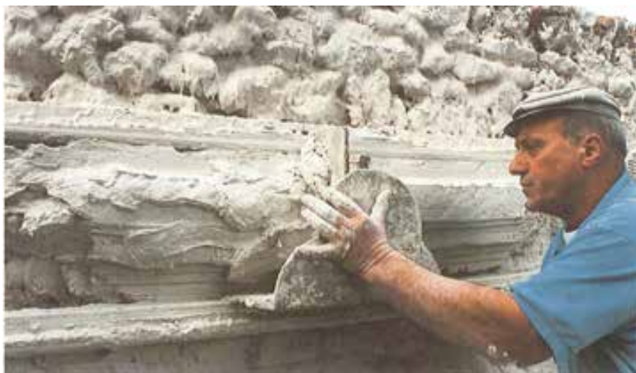
Fig.59. Le traînage répété du calibre le long des règles permet de former la moulure. Source : Frédéric Charpentier, Virginie Stelmach, et Michel Fontaine, Jean Fouin, « le plâtre, matériau noble », Maisons Paysannes de France , 2000, n° 138, p.23.
