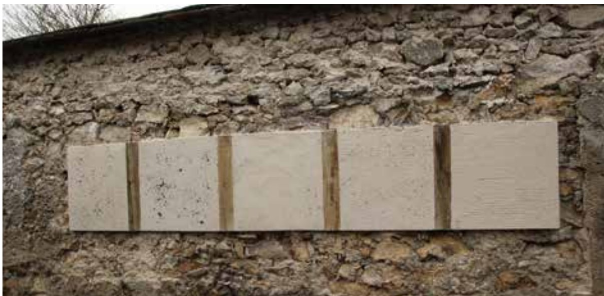
Fig.197. Tests d'enduits pratiqués par Philippe Bertone, Les Ateliers du Paysage, sur un mur du site des Murs à Pêches de Montreuil. Source : Tiffanie Le Dantec.
