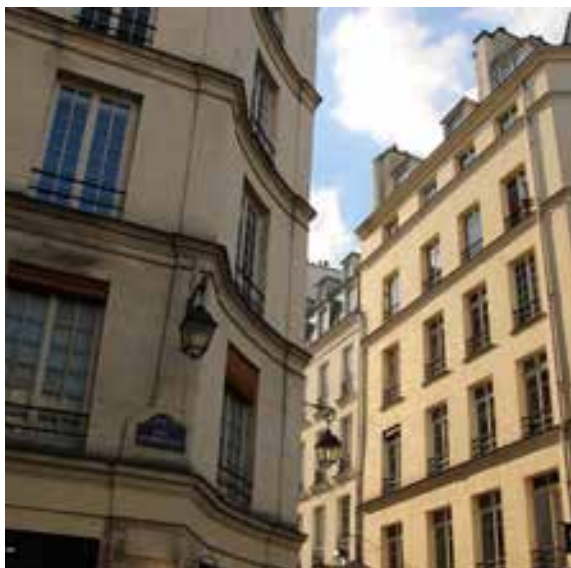
Fig.168. A gauche, édifices parisiens dont des bavettes de zinc recouvrent chaque bandeau, soulignant la façade de lignes noires. A droite, édifice versaillais dont les bandeaux ne sont pas recouverts de bavette, la façade est adoucie. Source : Tiffanie Le Dantec.
