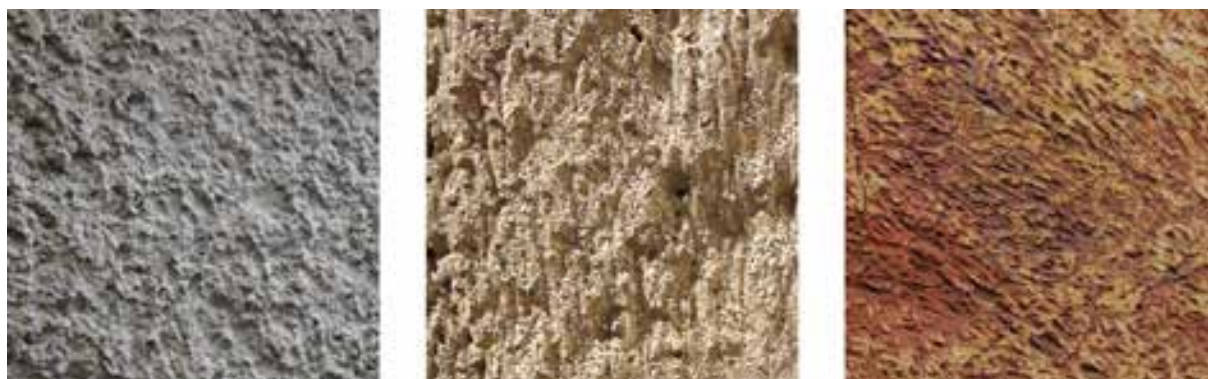
Fig.67. Crépis apparents sur les façades du Moulin des Clayes à Saint-Rémy-lès-Chevreuses (78), du 22 rue Geoffroy Lasnier à Paris (75), d'une maison à Théméricourt (95). Le premier est un crépi fait avec des grains solides, le troisième est fouetté au balai. La richesse des texture et des couleurs, leur altération par les peintures ou l'érosion rend chaque façade unique. Source : Tiffanie Le Dantec.
