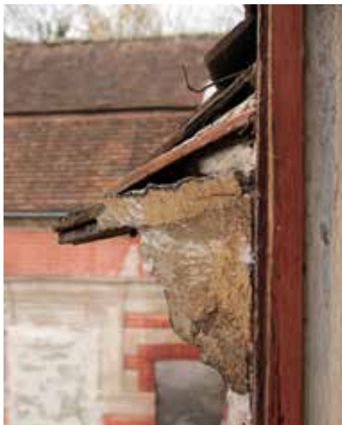
Fig.101. Ecuries de Morsang-sur-Orge (91). L'iconographie médiévale représente les maisons de faubourg avec un léger débord de la toiture en tuile, la dernière ligne de tuile créant l'effet goutte d'eau recherché pour éviter un ruissellement en façade. Source : Tiffanie Le Dantec.
