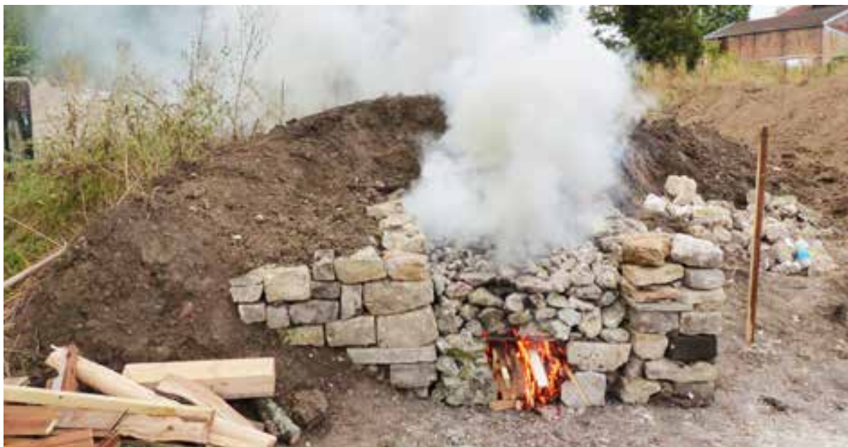
Fig.32. Four artisanal utilisé pour la cuisson des plâtras lors d'une formation menée par l'association Rempart à Montreuil le 15 septembre 2016. Source : Tiffanie Le Dantec.
