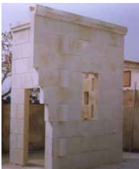
Fig.210. Prototype de l'ouvrage monté à Dakar au Sénégal, en carreaux de plâtre imbriqués. Source : Agence Mauduit & Alluin, Jean-Paul Mauduit.
