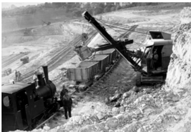
Fig.119. L'élévateur à godets servaient à dégager les marnes situées sur les masses de gypse. Les matériaux étaient ensuite transportés par n train interne à la carrière. Source : Carrière de Cormeilles-en-Parisis, années 1940, collection Musée du Plâtre.
