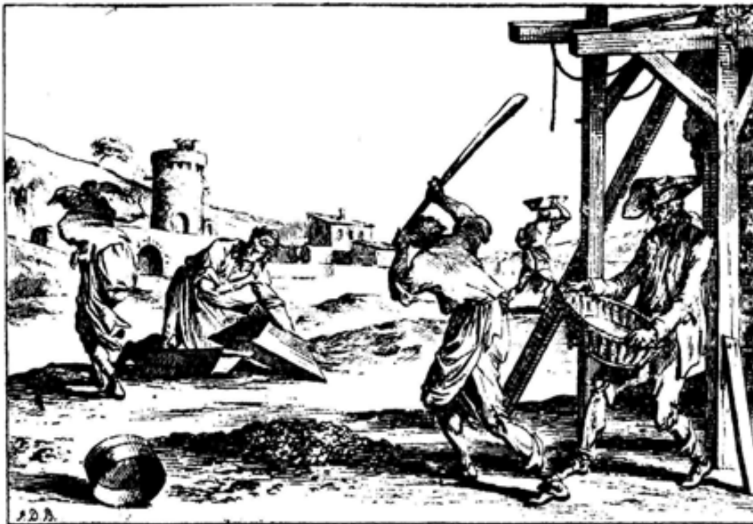
Fig.42. On distingue différents outils autour du battage et tamisage du plâtre : la batte, le panier à claire-voie, le sas, des auges et un sac de jute. Source : Jean Duplessis-Bertaux, Batteurs de plâtre , gravure au burin, seconde moitié du xviii e siècle. Marseille, MuCEM, inv. 1968.92.31. Reproduit in Guy Benhamou, Le Plâtre , Paris, J.B. Baillière, 1981, p. 29.
