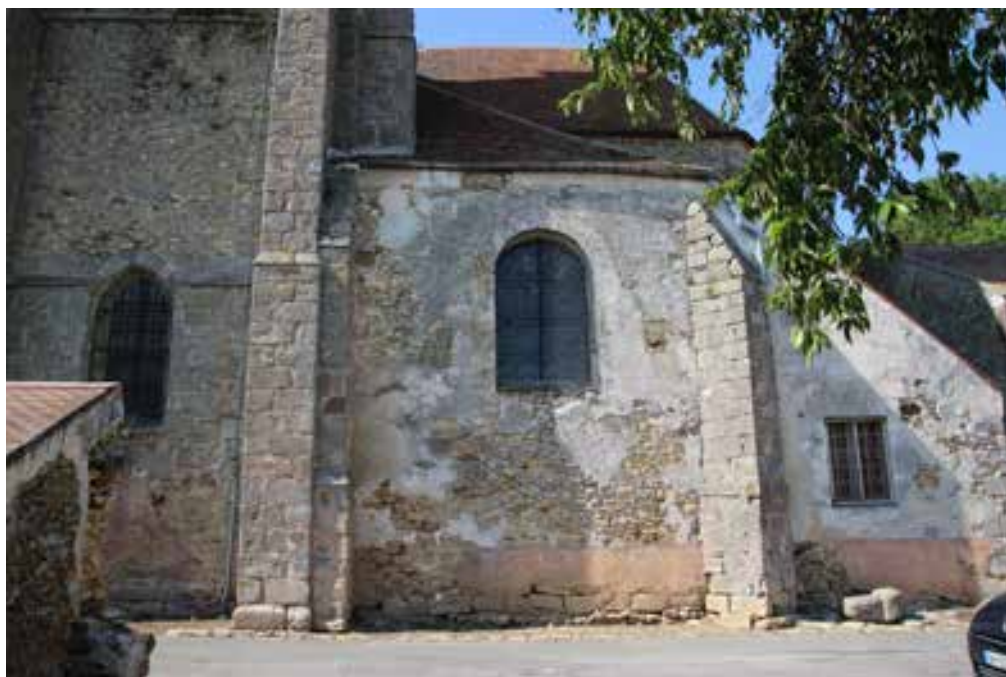
Fig.147. Eglise de Marles-en-Brie (77). Les enduits de cette église ont probablement été refaits vers 1930 de manière artisanale. Le plâtre est très grossier, mis en oeuvre en une seule passe. A cette époque, les édifices parisiens étaient enduits avec du plâtre fin industriel. Source : Tiffanie Le Dantec.
