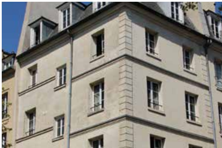
Fig.183. Angle de la rue Geoffroy L'Asnier et du Quai de l'Hôtel de Ville, à Paris. La couche de fluosilictae du ravalement des années 1969-70 pèle dans les niveaux supérieurs, plus soumis aux sollicitations météorologiques. Source : Tiffanie Le Dantec.
