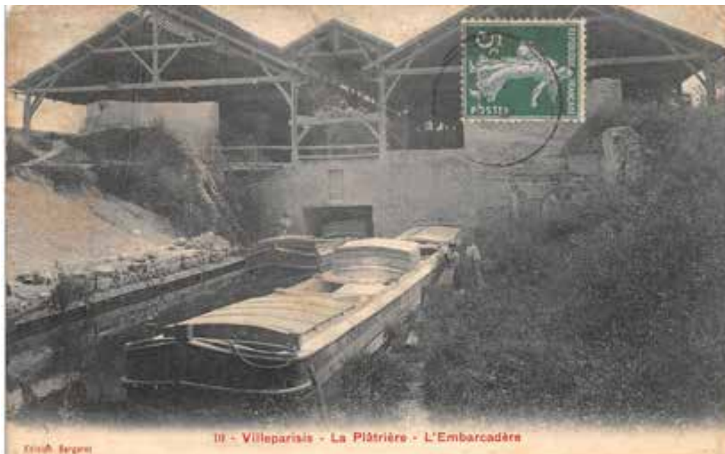
Fig.118. La plâtrière de Villeparisis est habilement construite : le moulin dont tombe le plâtre en poudre est situé au-dessus d'une voie d'eau, ce qui permet de charger directement la péniche. Source : www.delcampe.net
