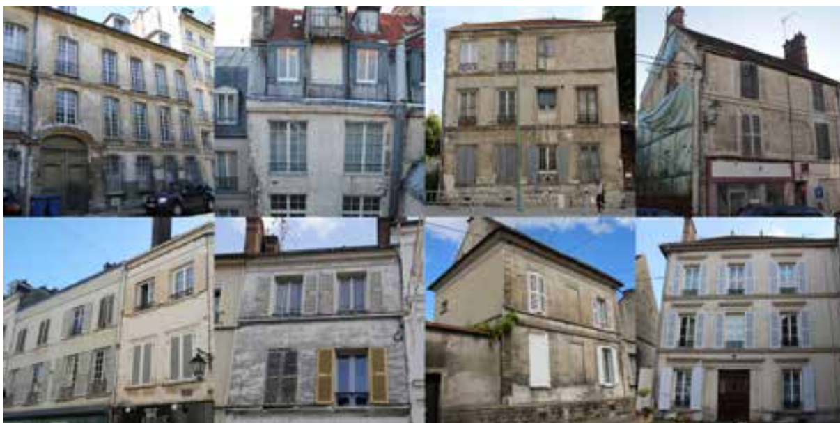
Fig.114. Mosaïque de façades de centre-ville francilien, dont les enduits sont coupés à la Berthelée. De gauche à droite et de haut en bas : Versailles, Paris, Arcueil, Linas, Provins, Fontainebleau, Meaux, Rozay-en-Brie. Source : Tiffanie Le Dantec.
