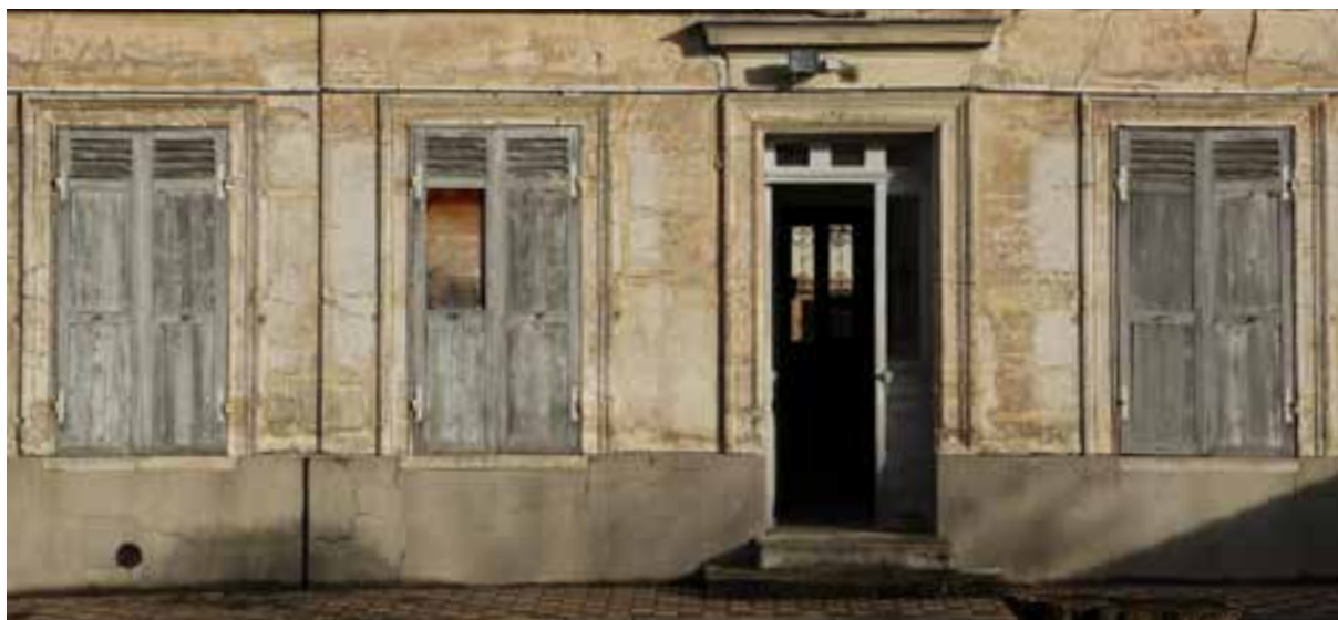
Fig.99. La façade sur cour du 13, rue Thibaut Chabrand à Cormeilles-en-Parisis (95). Les enduits de façade sont en plâtre sur cette maison de plaisance datant probablement du XVIII e siècle et remaniée au XIX e . Le soubassement,
