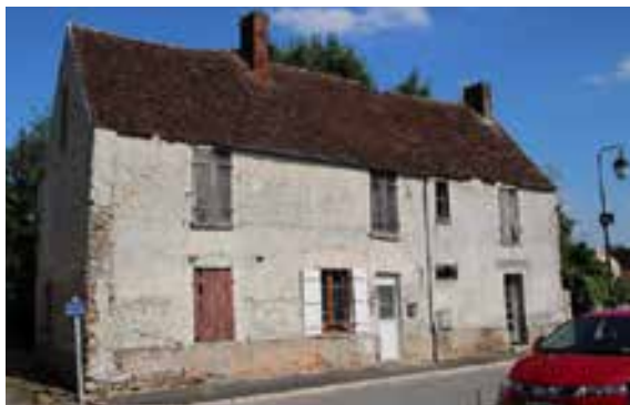
En haut (gauche) : maison de bourg à Marles-en-Brie. En haut (droite) : détail du pilastre gauche de la maison, en rouge on devine encore les traits en fausse chaîne d'angle mimant l'architecture de pierre. En bas (gauche) : ferme à La Houssaye-en-Brie, plâtre coloré avec des sablons. En bas (droite) : détail des ornements de la façade : bande en plâtre blanc lissé au pourtour de la façade et en encadrement des baies, le reste en plâtre ocre. (Photographies Tiffanie Le Dantec)
