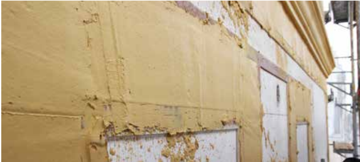
Fig.203. Plâtre actuel, il gonfle légèrement à la prise le long des règles en bois. Source : Tiffanie Le Dantec.
