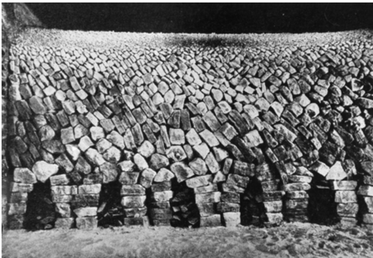
Fig.35. Un four à plâtre avant l'allumage à Noisy-le-Sec, 1925, Photo Auguste Robin, in La Terre , Larousse, 1925. Source : Musée du Plâtre.
