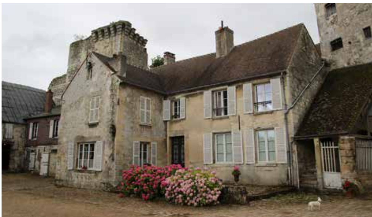
Fig.108. La maison située dans l'enceinte du Château de Montépilloy (60) est enduite de plâtre. Le pignon est beaucoup plus dégradé que le reste des façades, moins exposées. Source : Tiffanie Le Dantec.
