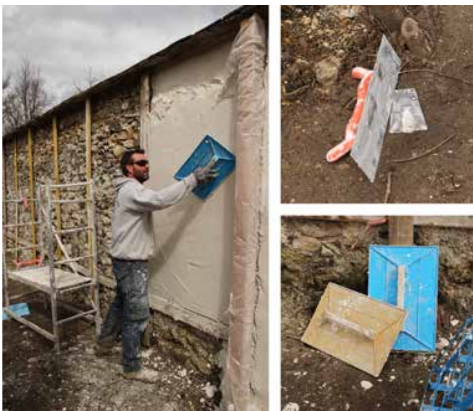
Fig.156. La lisseuse (Haut à droite) et la taloche (Bas à droite) sont des outils relativement récents dans la région parisienne, ils n'étaient pas utilisés dans la mise en œuvre traditionnelle. Source : Philippe Bertone ( Les Ateliers du Paysage ), Tiffanie Le Dantec.
