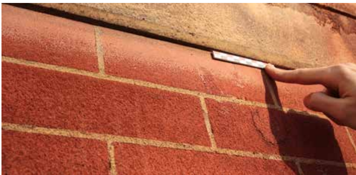
Fig.80. Faux briquetage des façades extérieures des Ecuries de Morsang-sur-Orge (91). La couche de finition teintée en rouge est creusée de faux joints de plâtre blanc. Source : Tiffanie Le Dantec.
