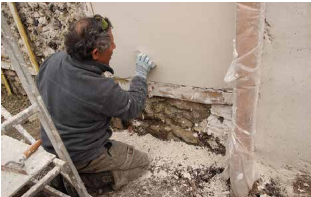
Fig.155. Couper un enduit à la berthelée entraîne une perte de matière et salit le chantier de copeaux de plâtre frais. Source : Philippe Bertone ( Les Ateliers du Paysage ), Tiffanie Le Dantec.
