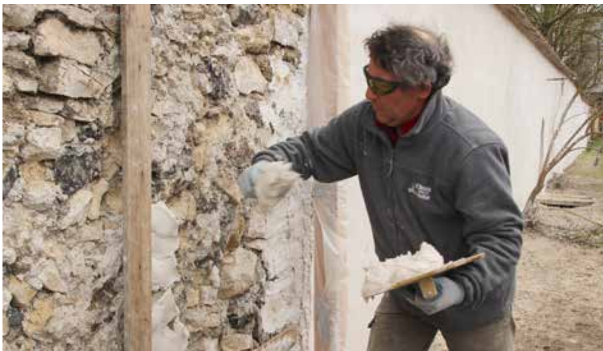
Fig.154. Le geste de la projection du plâtre à la truelle est vigoureux pour assurer la pénétration de l'enduit dans la maçonnerie. Source : Philippe Bertone ( Les Ateliers du Paysage ), Tiffanie Le Dantec.
