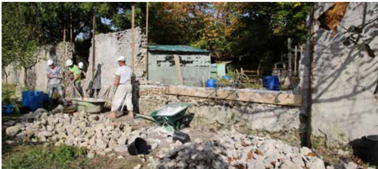
Fig.196. Chantier d'insertion professionnelle financé par la Ville de Montreuil. Remontage d'un mur au plâtre, sur le site des Murs à Pêches de Montreuil. Source : Tiffanie Le Dantec.
