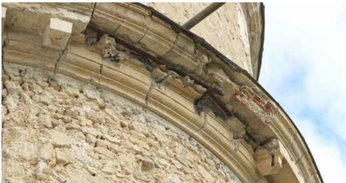
Fig.60. La corniche en plâtre et pierre du Château de Méréville (91). La corniche à modillons est fixée grâce à des armatures métalliques. Source : Tiffanie Le Dantec.
