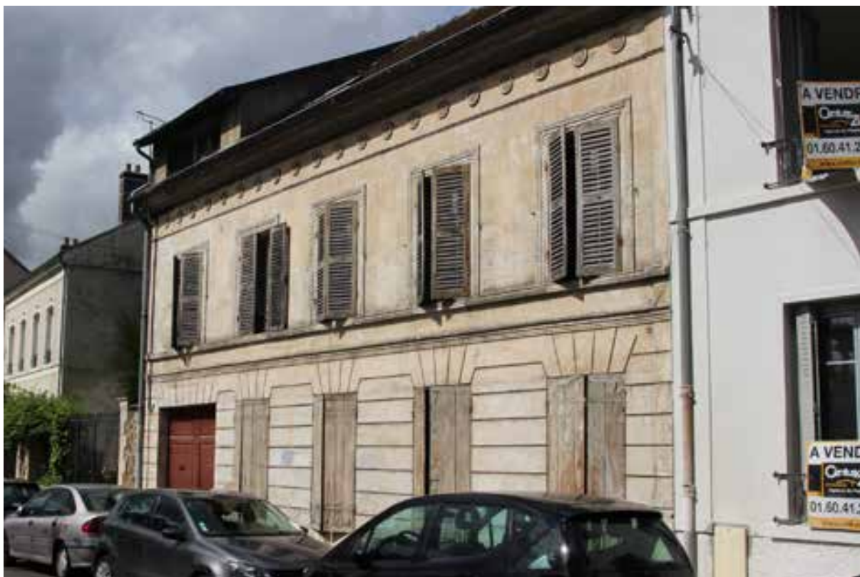
Fig.57. Une simple maison bourgeoise peut présenter une grande variété d'ornements en plâtre. Cette maison, rue de châage à Meaux (77), présente des corniche et bandeaux, un soubassement à refends tracés dans le plâtre, des encadrements de baie et une frise de motifs fleuris préfabriqués et collés. Source : Tiffanie Le Dantec.
