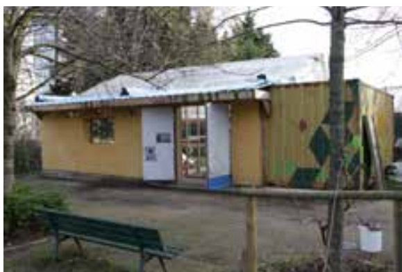
Fig.202. La Cabane Fleury, dans le square Emmanuel Fleury (Paris) allie une structure en paille a des enduits terre (intérieur) et des enduits plâtre (extérieur). Un défaut dans le soubassement (longrine en béton) a causé des remontées d'eau dans les enduits pendant les fortes pluies d'hiver et occasionne la dégradation des enduits (à droite, enduit terre). Constructeurs : BELLASTOCK, Pépins Production, Collect'if Paille. Source : Tiffanie Le Dantec.
