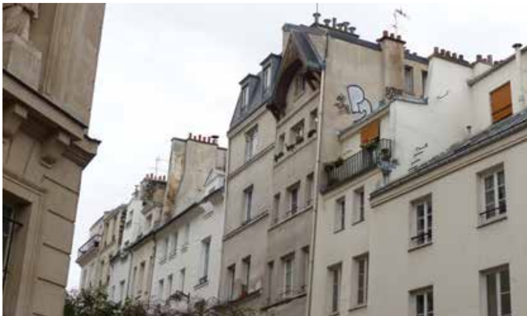
Fig.179. Façade ancienne enduite en ciment, rue Boutebrie, dans le Marais. Source : Tiffanie Le Dantec.
