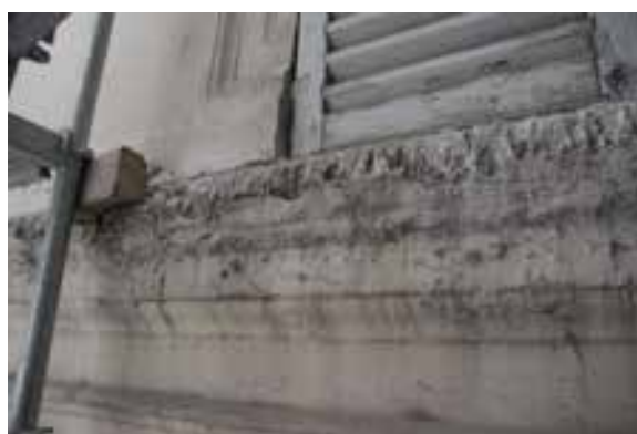
Fig.106. Dans la cour intérieure du 12, rue du Helder (75), datée du milieu du XIX e siècle, certaines moulures sont protégées par une bavette de zinc (gauche) et d'autres ont été laissées nues depuis (droite), occasionnant une forte pathologie sur la face du bandeau exposée à la pluie et au ruissellement. Source : Tiffanie le Dantec.
