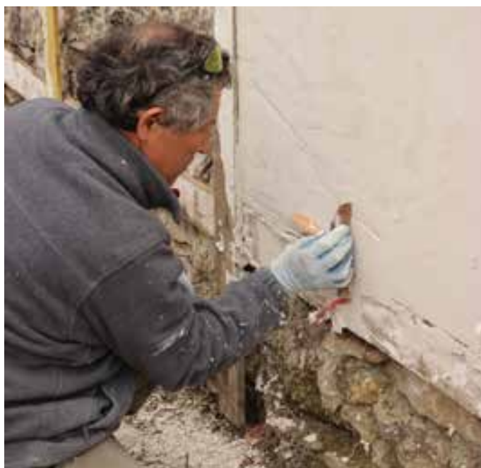
Fig.68. Finition coupée à la Berthelée, sur un mur à pêche à Montreuil (93), Philippe Bertone, les ateliers du Paysage. Source : Tiffanie Le Dantec.
