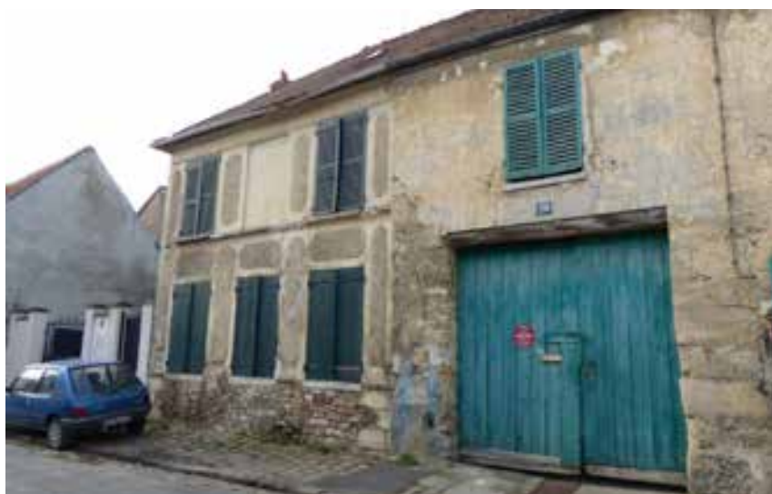
Fig.165. Une maison enduite au plâtre et badigeonnée, dans les rues du Vieux Village de Goussainville (95). Source : Tiffanie Le Dantec.
