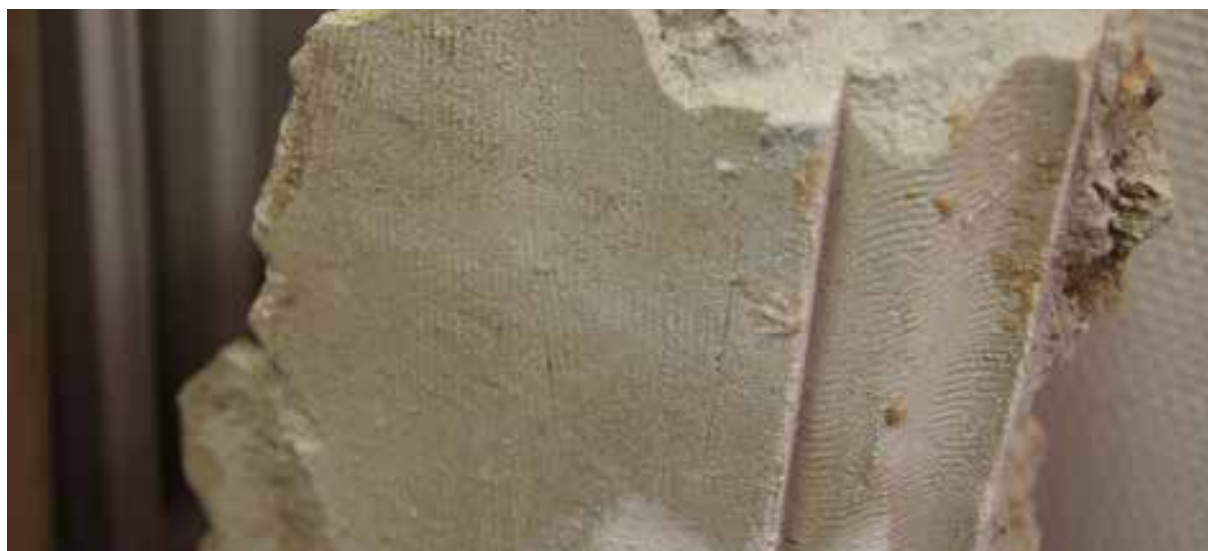
Fig.74. Détail d'un enduit intérieur strié à la gradine, dans la grotte du château des Gondy, 1580-90 (fouilles archéologiques 2017, Bruno Bentz, OMAGE). Source : Tiffanie Le Dantec.
