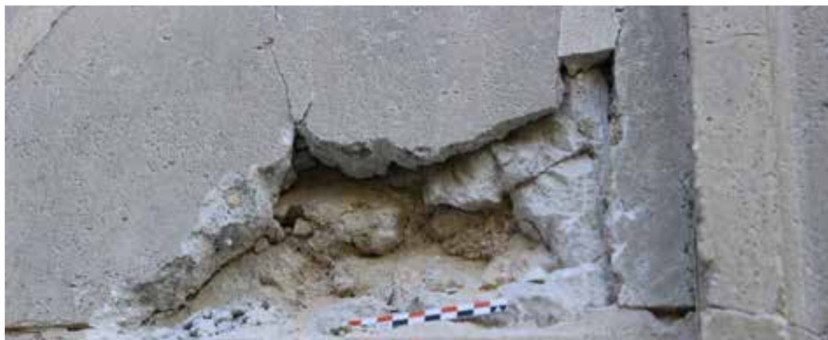
Fig.206. Les enduits de la façade Ouest du Château de Méréville présentent du verrage, la surface de l'enduit est peu poreuse et semble vitrifiée. Source : Tiffanie Le Dantec.
