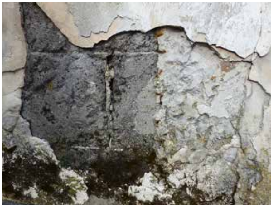
Fig.162. Carreaux de béton de plâtre avec mâchefer, liés au plâtre et recouverts d'enduits plâtre. Maison des carriers, rue des Bas Pays, Romainville (93). Source : Tiffanie Le Dantec.
