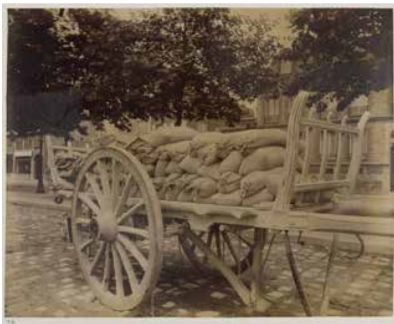
Fig.144. Le transport du plâtre au début du XX e siècle : des sacs en jute sur un tombereau. Source : Eugène Atget, Voiture pour le transport des Plâtres , 1910. BnF, RESERVE PET FOL-LD-26.
