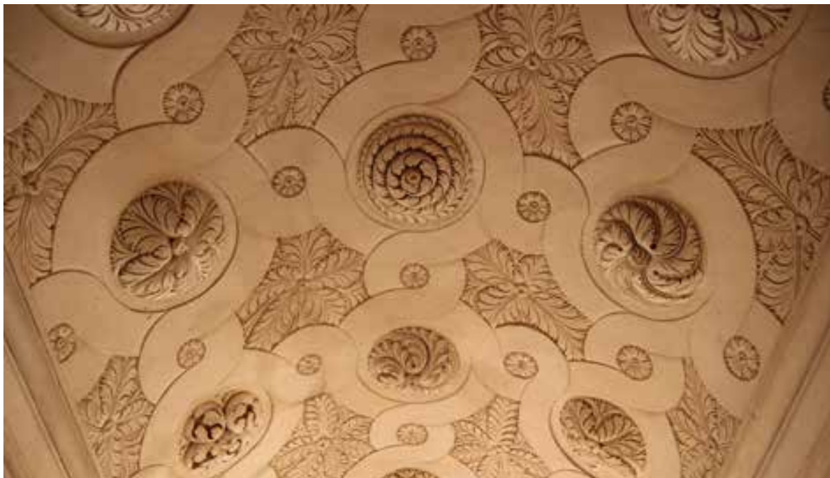
Fig.58. La voûte de l'escalier de l'ancien château de Volonne (04) est ornée de gypseries datées du milieu du XVIIIe siècle. Source : Tiffanie Le Dantec.
