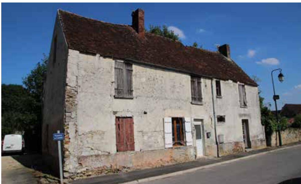
Fig.100. Cette maison, à Marles-en-Brie (77) a un soubassement en mortier romain, dont les tuileaux mêlés à la chaux donne à l'enduit un couleur rose. Ce mélange a été très utilisé au XIX e et XX e siècle avant l'utilisation plus générale des ciments industriels. Source : Tiffanie Le Dantec.
