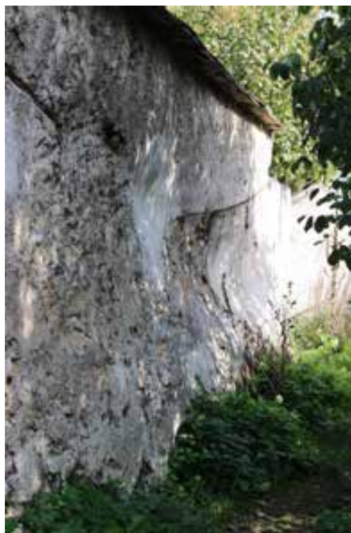
Fig.205. La déformation du plâtre est due au phénomène du fluage qui permet aux cristaux de gypse de glisser les uns sur les autres en présence d'eau. Source : Tiffanie Le Dantec.
