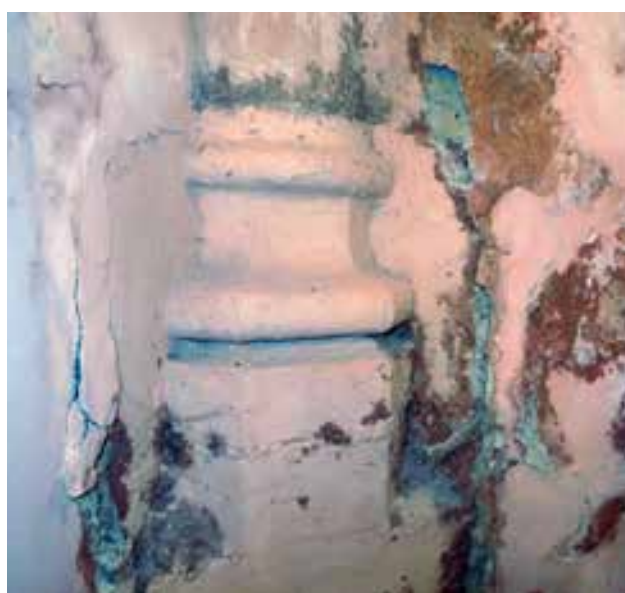
Fig.161. L'église d'Othis (77) possédait des enduits intérieurs en plâtre, partiellement recouverts d'enduits de ciment. En présence d'eau capillaire, la formation d' ettringite a provoqué le gonflement et la fissuration des enduits de ciment. Source : Aurélie Randon, architecte du patrimoine.
