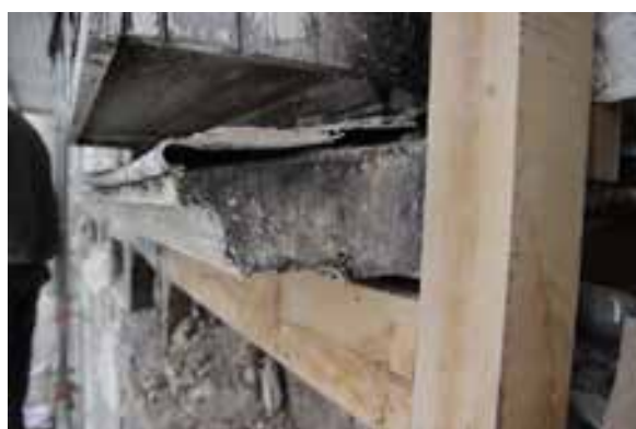
Fig.106. Dans la cour intérieure du 12, rue du Helder (75), datée du milieu du XIX e siècle, certaines moulures sont protégées par une bavette de zinc (gauche) et d'autres ont été laissées nues depuis (droite), occasionnant une forte pathologie sur la face du bandeau exposée à la pluie et au ruissellement. Source : Tiffanie le Dantec.
